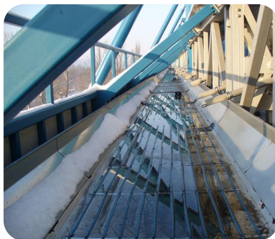
Applicazione canali di scolo
